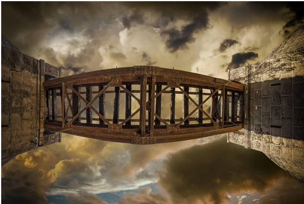
Puente ferroviario de acero desde abajo en panorámica. / Chechi Peinado (CC 2.0)
