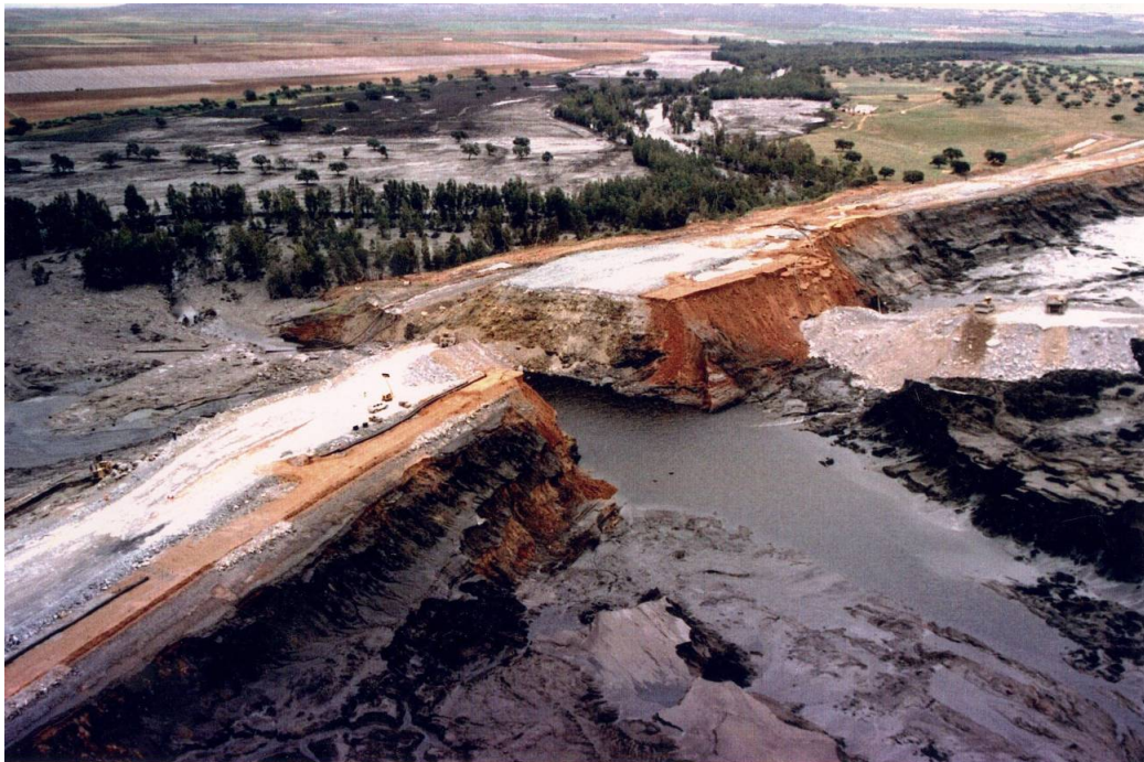
Vista aérea de la rotura de la balsa que provocó el vertido / EFE
