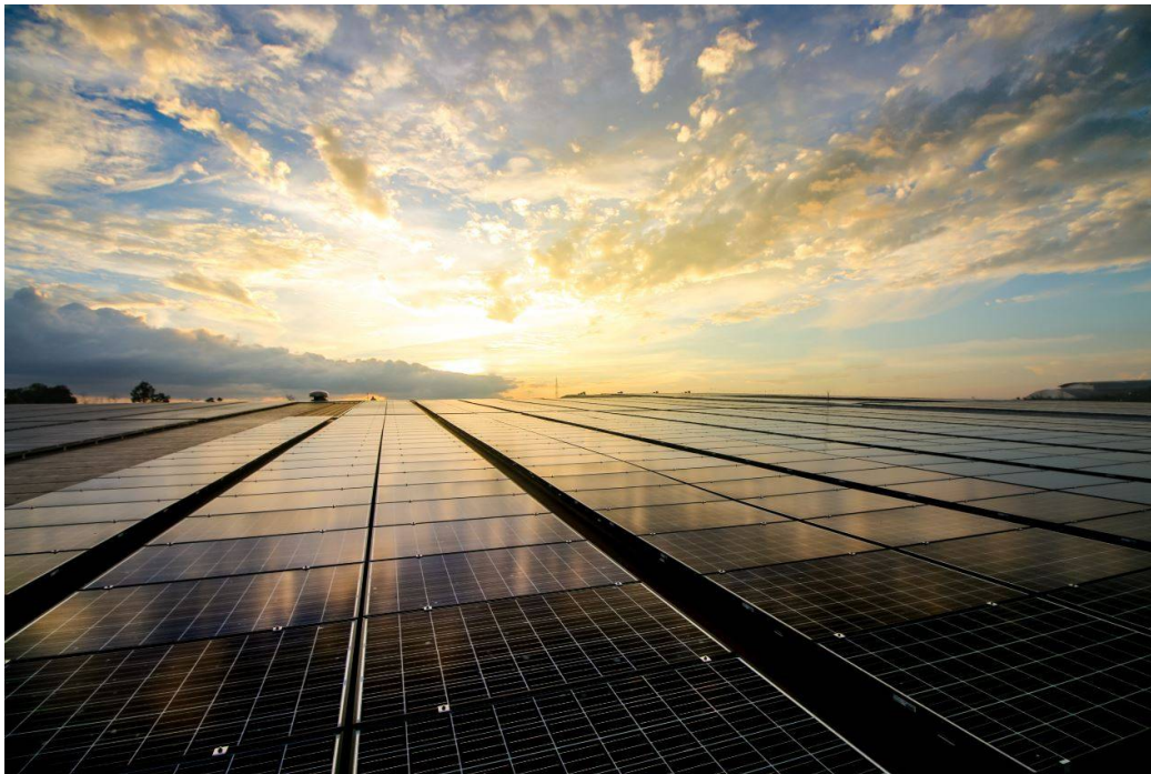
Paneles solares en una instalación. / Adobe Stock
