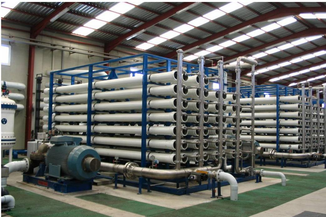
El interior de la planta desaladora de Cuevas del Almanzora (Almería) muestra el proceso y las membranas de ósmosis inversa. Foto: Iván Muñoz.
