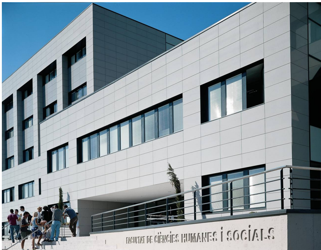
Fachada Ventilada cerámica utilizada en el edificio de la Facultad de Ciencias Humanas y Sociales de la Universitat Jaume I de Castellón. Imagen: ITC.
