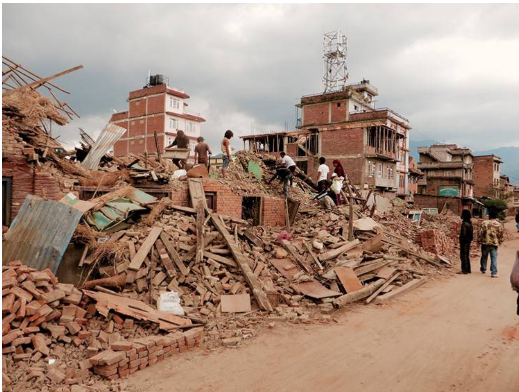
Daños causados por el terremoto en Nepal. / SIM Central and South East Asia .
