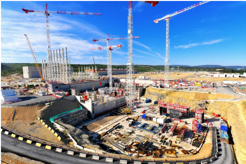
Estado actual de las obras del International Thermonuclear Experimental Reactor. / ITER
