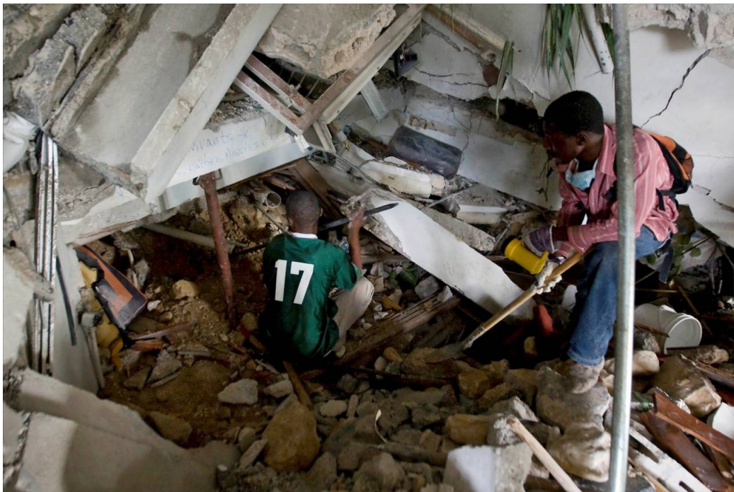
Casa destruida durante el último gran terremoto de Haití / ONU
